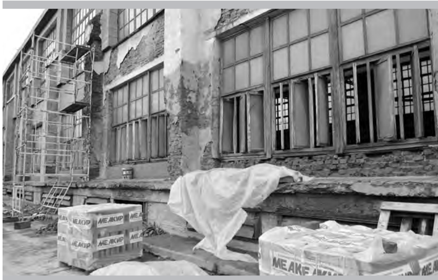
Работы на фасаде третьей серии электролиза начались недавно
