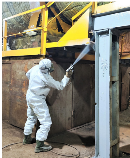
На заключительном этапе – покраске конструкций – чистильщик металла Юрий Иванович Щелгачёв .
