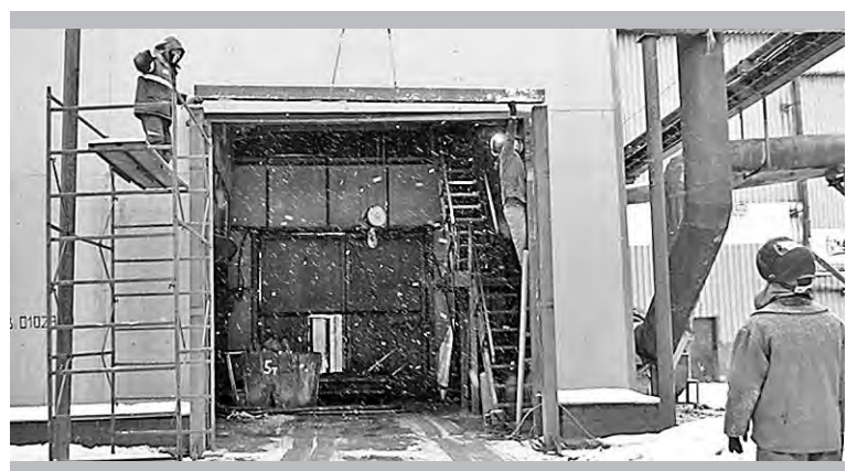
Монтаж новых ворот
