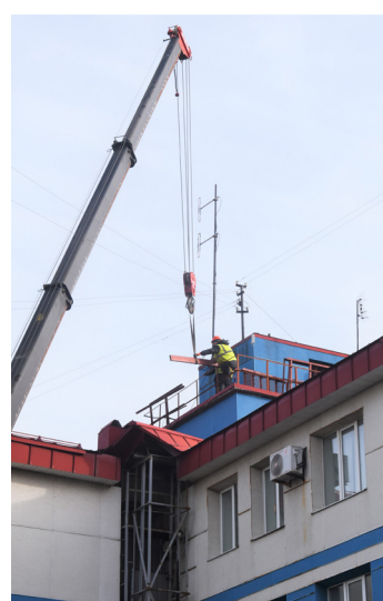
Монтаж обслуживающей площадки
