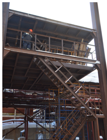
Строится узел фасовки карналлита
