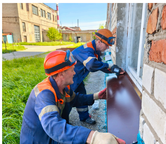
За установкой подоконных отливов на здании бытового корпуса № 2 – монтажники РВУ Анатолий Попов и Сергей Брезгин
