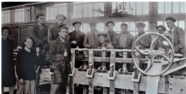
Монтаж электролизёра, 1936 г.
