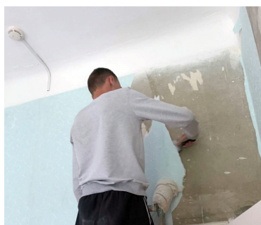
Никита Патрушев, участник первой смены, подготавливает корпус №4 санатория-профилактория СМЗ для ремонтных работ
