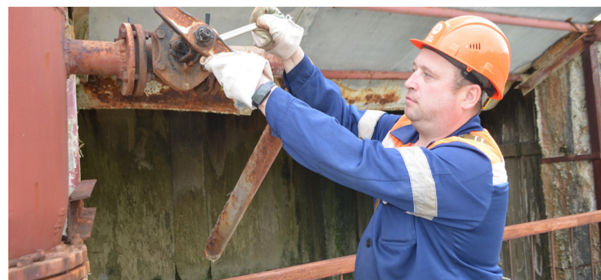
Слесарь по ремонту оборудования тепловых сетей Александр Самсонов
