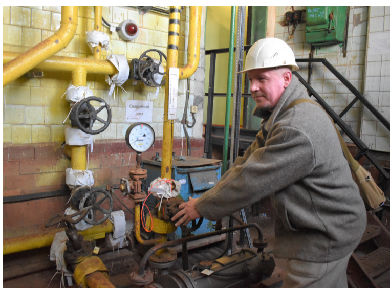
Дмитрий Разин вручную запускает подачу четырёххлористого углерода в цех № 7
