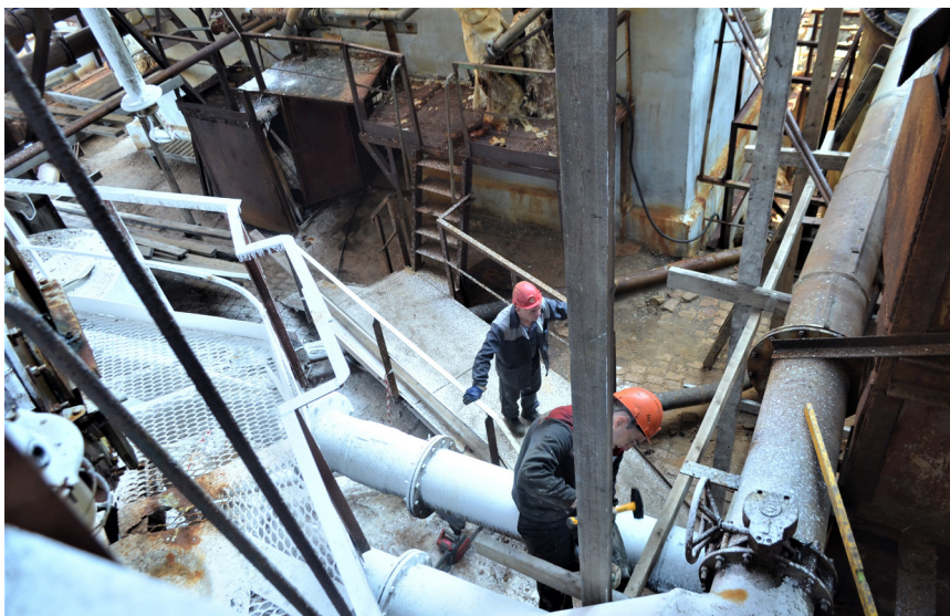
Будни большого ремонта
