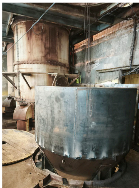
Монтаж металлического кожуха нового фильтра близится к концу
