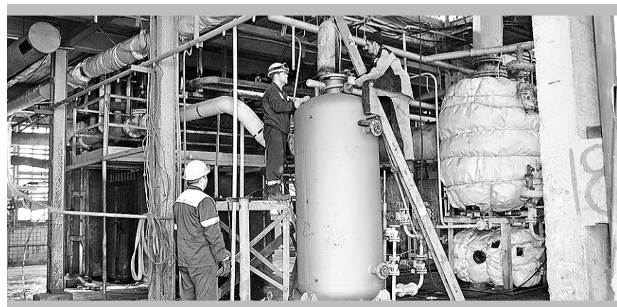
Монтаж промосуда № 4 в мае прошлого года
